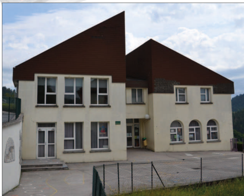
École du Centre, site des Primevères (Sapin88, Licence CC BY-SA 3.0)
